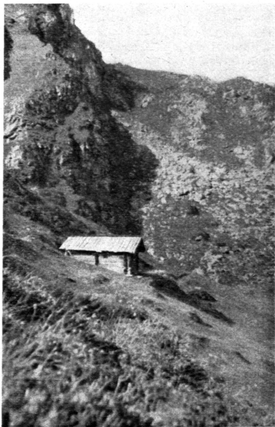
Abb. 4. Bergmahdhütte auf 2400 m. Grundfläche etwa 4 \times 6 m; lichte Höhe 1,70 m; ihre Rückwand wird durch Felsen gebildet. Über der offenen Herdstelle ist ein Rauchabzug angeordnet.
