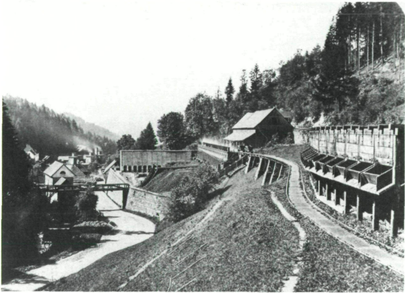
Abb. 13: Eisenwerk Lölling um 1875/80. Undatierte Fotografie im Archiv des Landesmuseums für Kärnten, Klagenfurt. Rechts Erzfüllbanke mit Bahn zu den beiden Schachtofen-Röstanlagen in Bildmitte, darüber Koblbarren, darunter bzw. davor Erzlagerplatz; links im Hintergrund Hochofenanlage.
