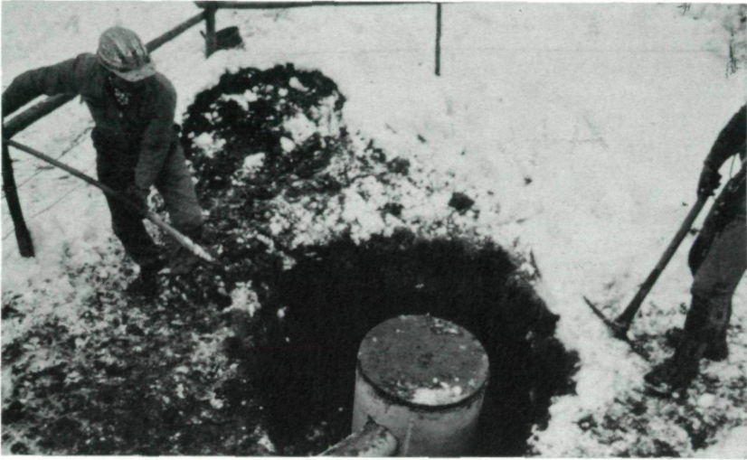
Abb. 2: Sicherungsarbeiten am Schacht. Photo: Harald LANGER.
