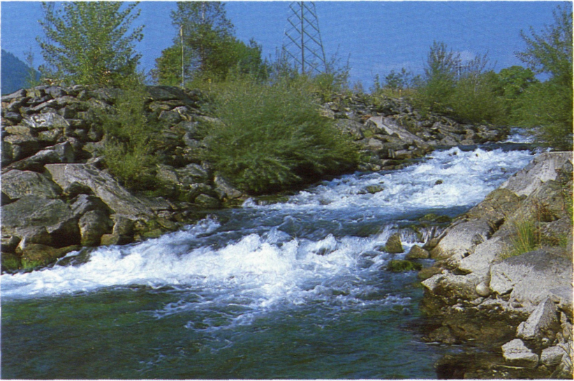
Abb. 8: Absturzrampe des Rottensteiner Vorflutgerinnes, welche von Huchen im Rahmen der Laichwanderungen überwunden wurde.
