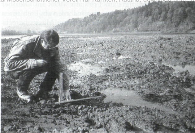
Abb. 2: Mit der Methode des Rückbaggerns konnte jedes erwünschte Niveau erzielt werden. Der im Bild ersichtliche großflächige Bereich liegt nun nach Flutung der Baustelle im Durchschnitt 10–20 cm unter dem Niveau des Stauzieles.
