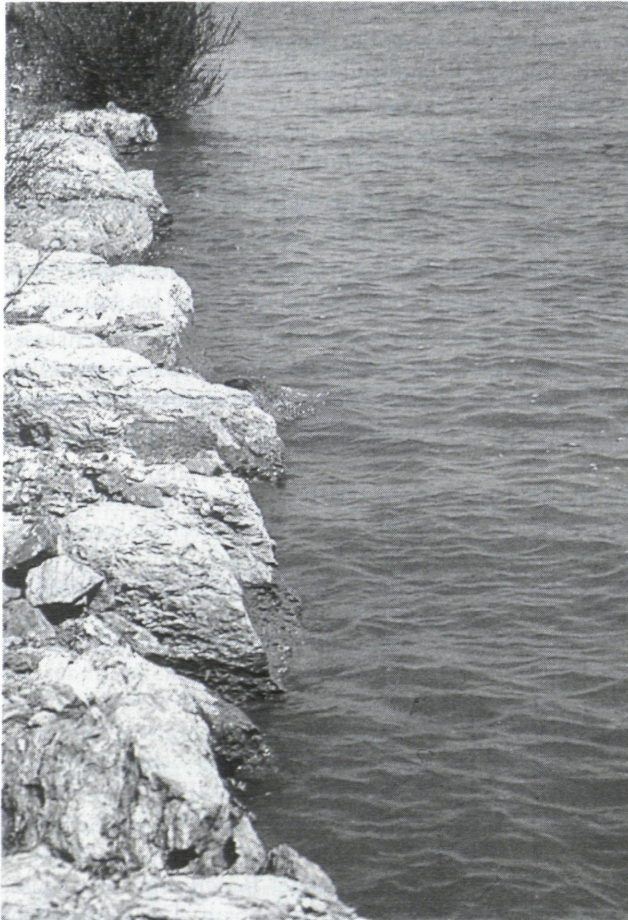
Abb. 8: Das Ufer wurde im Süden gegen den Stromstrich abwechselnd mit grobem Blockwurf und Weidenrollen gesichert.
