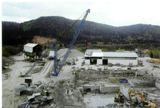
Abb. 5: Der 1995 begonnene Tiefbau von Norden; am linken Rand des Tiefbaues der Derrick-Kran, der bis etwa 40 to schwere Blöcke zu heben vermag. In den Hallen hinter dem Tiefbau werden die Blöcke zu Schnittware verarbeitet, am linken Bildrand die Brechanlage mit Trockenklassierung. Foto: Archiv Kogler
