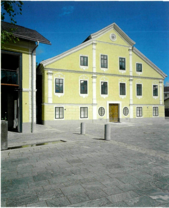
Abb. 10: Pflaster aus St. Urbaner Metadiabas („Carat“) am Vorplatz des ehemaligen Silbernagl'schen Schlosses in Ferlach (später Verwaltungsgebäude der KESTAG), wo 1997 die Kärntner Landesausstellung stattfand. Die Pflasterplatten zeigen sehr schön die unterschiedlichen Feinstrukturen dieser Metavulkanite. Foto: Archiv Kogler
