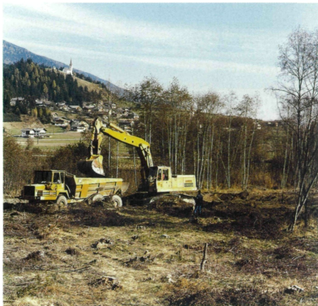
Abb. 5: Abhebung des alten Oberbodens und Entnahme großer Pflanzen- ballen (Seggen, Hochstauden, Röhricht). Im Hintergrund das Dorf Strassen mit St. Jakob (Foto: TIWAG)
