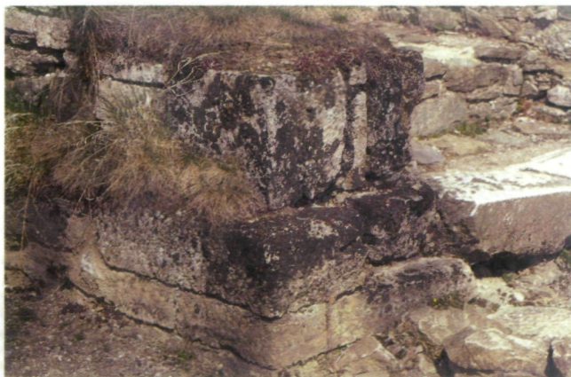
Abb. 67: Marmor-Treppenaufgang zwischen Praetorium und Tempelbereich zum sog. Felsenheiligtum
