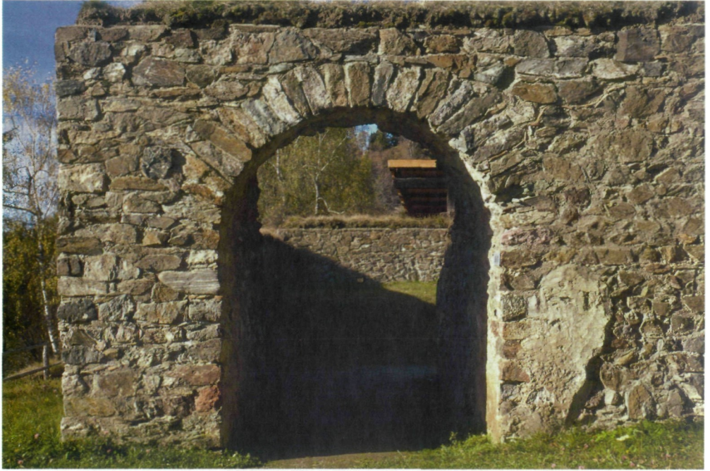
Abb. 47: Torbogen in den Südhangbauten, restauriert, Gebäude SH/14, Torbogen nur aus Vulkaniten der Magdalensberg-Folge aufgebaut. Rechts unten Reste vom Originalverputz, Ziegeltrennlage rechts oben am Torbogen
