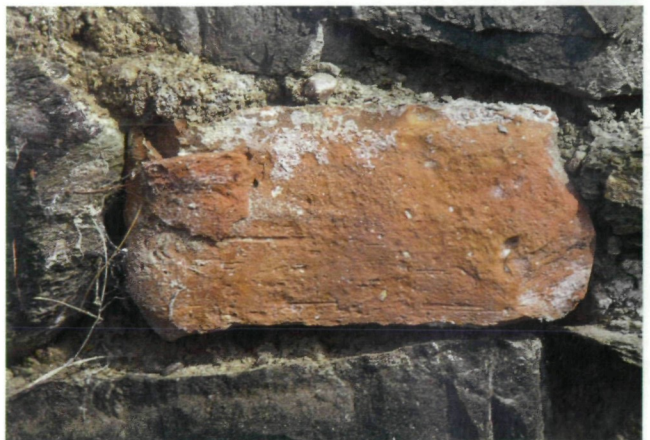
Abb. 84: gebrannter Ziegelstein, lange Wand östlich Eisenmuseum, Größe 15 x 7,5 cm, 150 cm über Niveau
