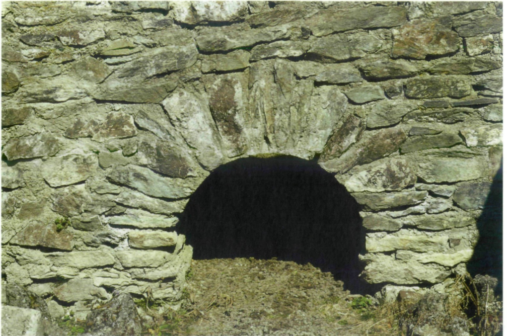
Abb. 48: Bogenförmiger Durchlass für die Warmluftheizung im Badbereich (Schwitzbad). Ausführung der Bogensteine aus anstehenden Vulkaniten des Magdalensberges
