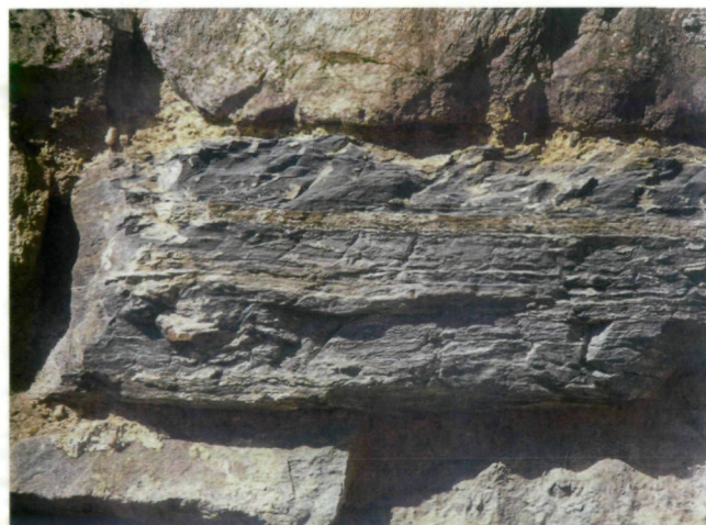
Abb. 13: Feinlagiger blaugrau verwitternder Staubtuff mit bräunlichen tuffitischen Zwischenlagen, Westwand des Praetoriums, Größe 36 x 14 cm, 170 cm über Niveau
