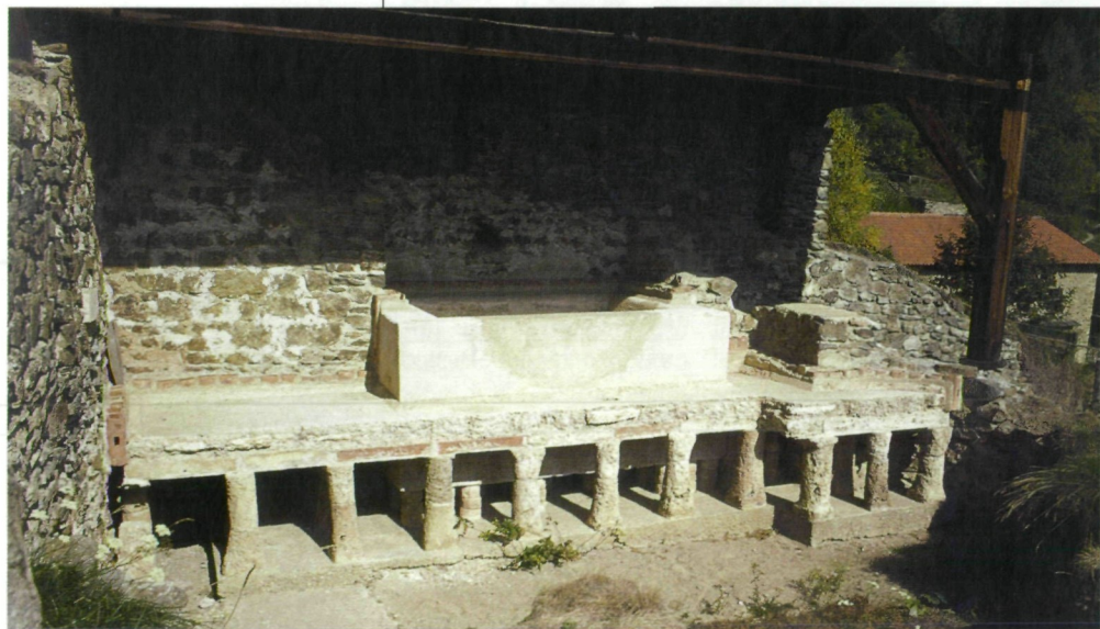
Abb. 93: Badeanlage, Badewanne mit Fußboden- und Wandbeheizung (Hohlziegel), doppelkonische Säulchen tragen die großen überbrückenden Ziegel und Steinplatten (Kalksinter) der Abdeckung des Heizungsraumes, die zuoberst mit einer opus caementitium -Betondecke den Fußboden des Wannenraumes bildet. Säulchen und Steinplatten aus Kalksinter von Peratschitzen (Bez. Völkermarkt), vergl. Titelbild
