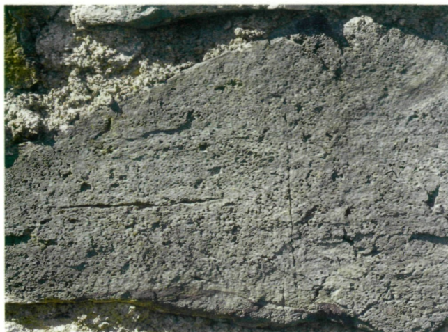
Abb. 11: Meta-Basalt (Lava) mit zahlreichen kleinen Gasblasen (ursprüngliche Kalzitfüllung herausgewittert). Ost-exponierte Wand zur Bäckerei, Villa mit Badeanlage, Größe 47 x 22 cm, ca. 70 cm über Niveau
