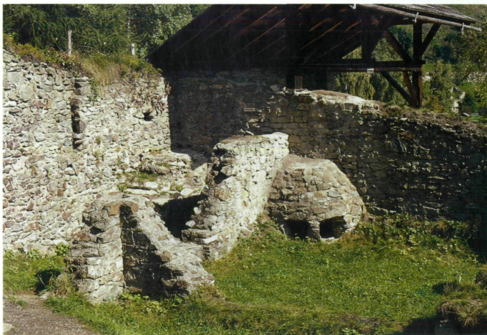
Abb. 49: Heiz- und Kesselanlage (praefurnium) für die Warmluftheizung (hypocaustum) des dahinter liegenden Warmbaderaums mit der großen Badewanne (Abb. 95). Villa mit Badeanlage, Gebäude AA/8
