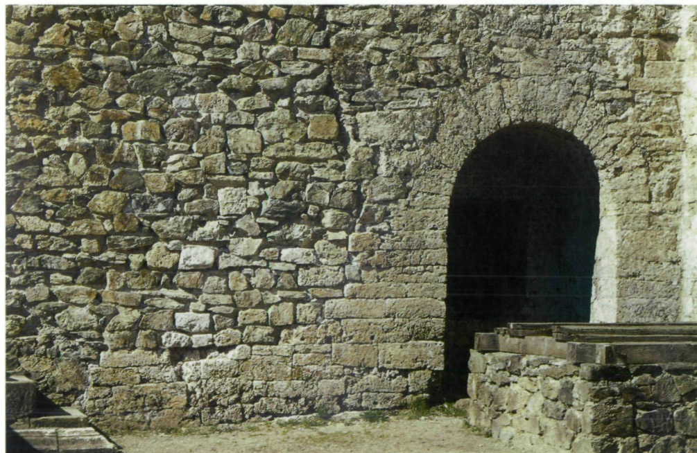
Abb. 46: Torbogen in der nördlichen Westwand des Praetoriums, vollständig aus sorgfältig geschnittenen Kalksinter-Steinen (davon 21 Bogensteinen) aufgebaut. Davor rechts unten im Bild eine gemauerte Zisterne
