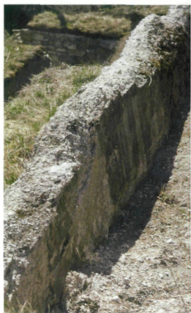
Abb. 94: Gussmauerwerk ( opus caementitium ) eines Wasserbeckens (Zisterne oder Absetzbecken?) auf der Südseite der Badeanlage, Gebäude AA/30. Länge der Mauer 9 m, Gesamtgröße des Wasserbeckens ca. 6 (5,5) m x 9 m, rezente Mauerhöhe ca. 120 cm, Beckengröße ca. 50 m 2
