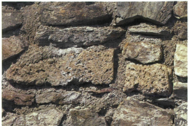
Abb. 76: Zwei Mauersteine des porösen Kalksinters von Peratschitzen in einer Blindmauer der Südhang- bauten
