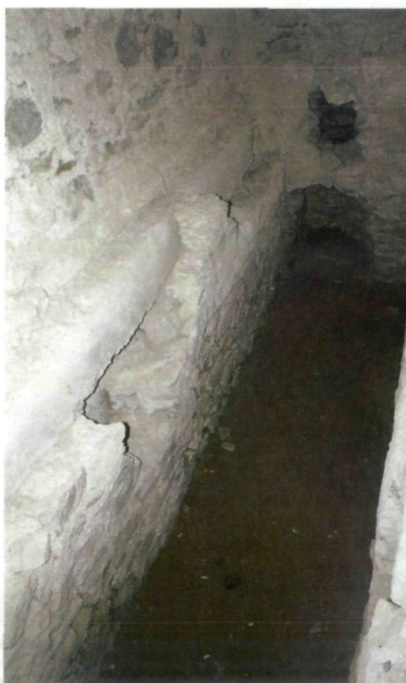
Abb. 95: Heizungskanal für den Apsidensaal A des RP-Gebäudes (Nordwand). Kanal war mit Stahlstäben, Ton- oder Kalksinterplatten und 16 cm Beton ( opus caementitium ) abgedeckt. Nachweislich der erste „Stahlbetonbau“ in der Antike (EGGER 1949, LAMPRECHT 1993), vergl. Rekonstruktion Abb. 96
