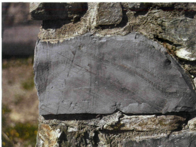
Abb. 14: Violetter Staubbuff mit dunkleren Lagen. Blick auf glatte Schieferungs- fläche, Podest am Praetorium (Süd- wand-Ecke). Größe ca. 34 x 16 cm
