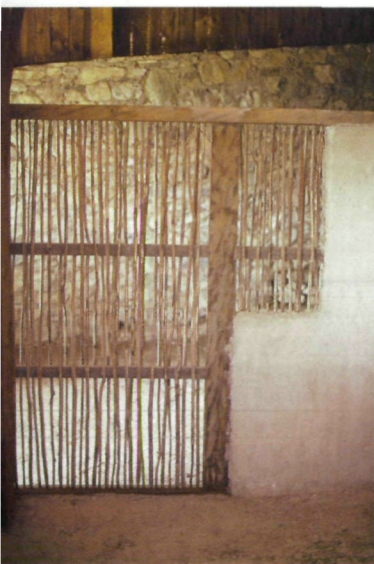
Abb. 88: Nichttragende Fachwerkwand aus Rutengeflecht mit beworfenem Mörtel (rekonstruiert) zur Raum- unterteilung, Wohn- und Werk- stättenviertel, Raum NG/33
