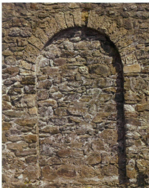
Abb. 45: Verblendeter Torbogen, Ostwand des Prätoriums (ehemaliger Durchgang zum Tempelbereich?), Bogen aus 21 bearbeiteten trapezoiden Kalksinter-Steinen ausgeführt. Herkunft: Peratschitz bei Kühnsdorf, Bez. Völkermarkt
