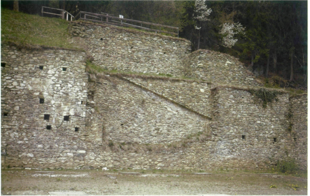
Abb. 37: Nordwand des Praetoriums mit Öffnungen für Hangentwässerung und schräge Aussparung für hölzerne Dachkonstruktion
