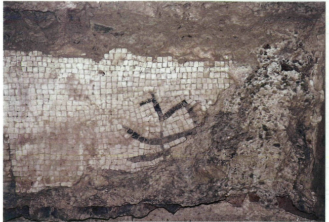
Abb. 83: Zweifarbiges Mosaik an der Nord- wand des Apsidenraumes im RP- Gebäude mit keltischem Pferde- motiv. Das Mosaik befindet sich direkt über dem später eingebauten Heizungskanal im Apsidensaal. Rechts: Reste von Römischem Beton
