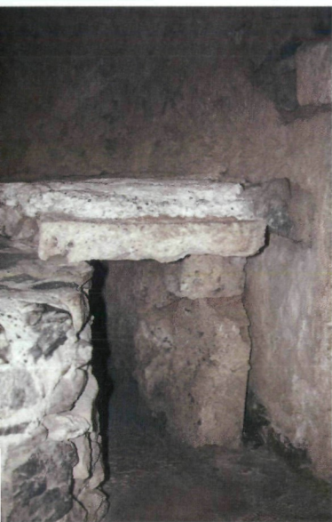
Abb. 92: Detail der Fußbodenheizung ( hypocaustum ) an der Apsis mit Brunnen im RP-Apsidensaal (vergl. Abb. 91). Rechte Stütze und auflagernde 5 cm dicke Platte aus Kalksinter. Über der Kalksinterplatte ca. 5 cm opus caementitium (Römischer Beton)
