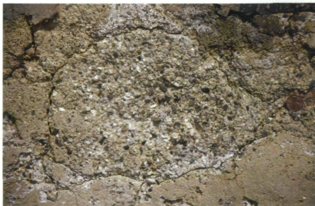
Abb. 97: Putzreste an der Außenmauer des Gebäudes SH/8, mehrschichtig, Grobsand bis Feinkies-Anteil in der unterliegenden Putzschicht, die oberste glatte Schicht ist mit Feinsand ausgeführt. Bildbreite ca. 30 cm
