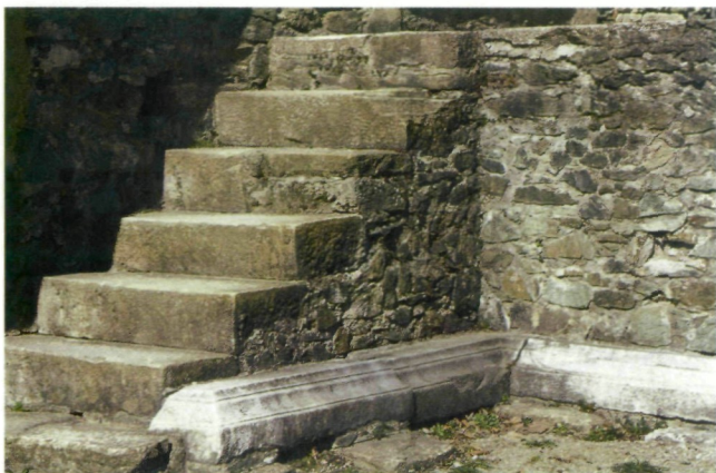
Abb. 66: Marmortreppe und Reste der marmornen Sockelverkleidung am Podium des Praetoriums (Südseite)
