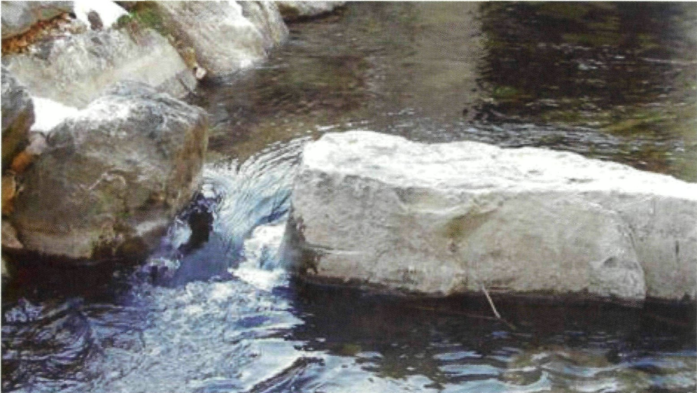
Abb. 11: FAH Schütt, Übergang Becken 31-30, 40-50 l/s.
