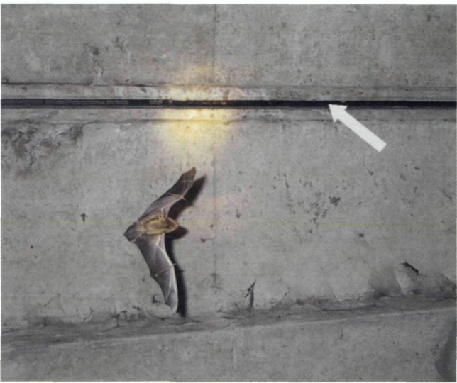
Abb. 2: Quartier von Großen Abendseglern ( Nyctalus noctula ) in einer Autobahnbrücke bei Klagenfurt, Bild: C. Hebein. Pfeil markiert das Quartier in der Dehnungsfuge.
