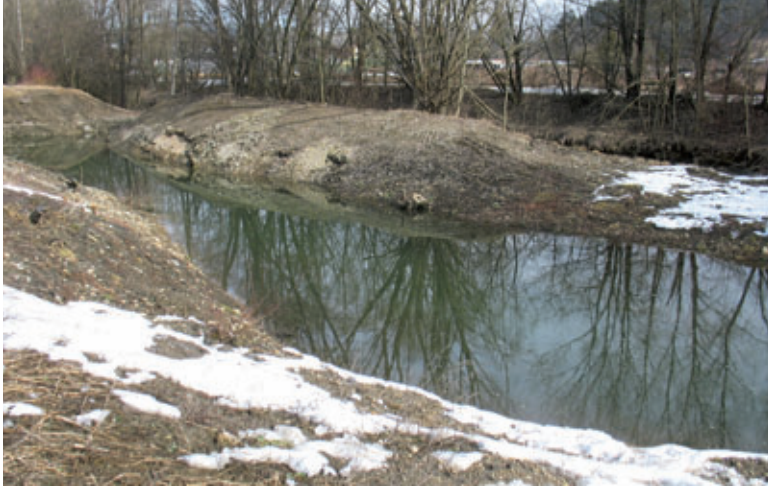
Abb. 22: Der Ersatzlebensraum „Glanaufweitung und Amphibientümpel 1“ (6.198 m 2 ) ist an den Glanfluss angebunden und wird bei höherem Wasserstand von diesem dotiert, 26. 2. 2009. Foto: W. R. Franz
