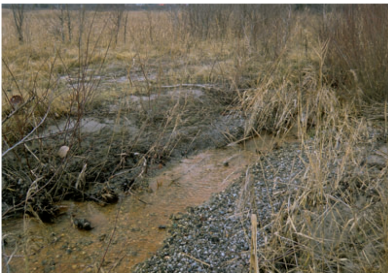
Abb. 6: Das mit Steinplatten ausgelegte künstliche Bachbett des Rauscherbaches erlaubt hochwasserbedingte Überflutungen des Moores erst 200 m nördlich der Bahn.
