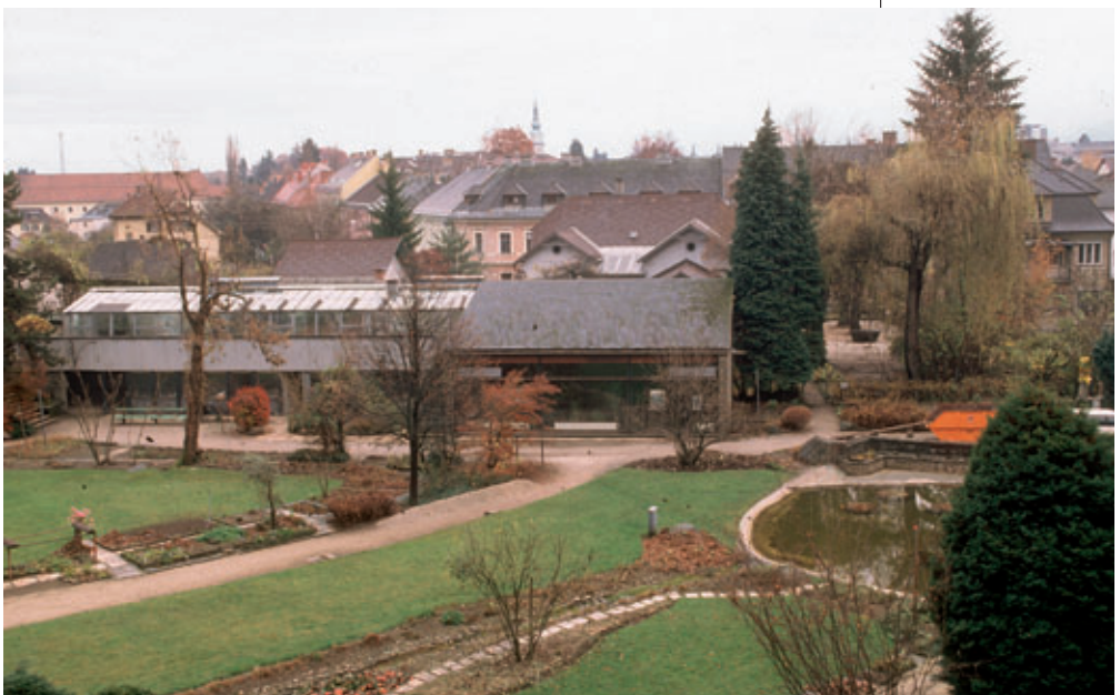
Abb. 11: Das Betriebsgebäude des Botanischen Gartens mit Vortragshalle und Glashaus (1994). Foto: Landesmuseum für Kärnten/KBZ, M. Kosch
