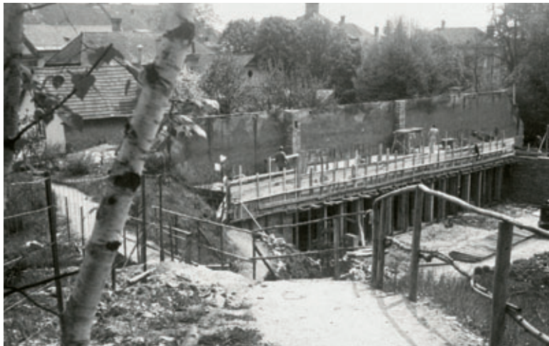
Abb. 6: Beginn der Errichtung eines Betriebsgebäudes im neuen Botanischen Garten 1960. Foto: Landesmuseum für Kärnten/KBZ, F. Zeitler
