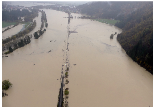
Abb. 20: Gail bei Tröpolach. Der gesamte Talboden und die in der Zwischenzeit stillgelegte Eisenbahnstrecke zwischen Hermagor und Kötschach-Mauthen wurden überflutet. Foto: BMI u. AKL, Abt. 12
