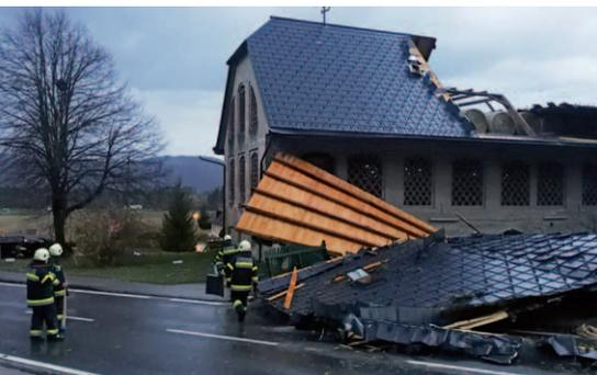
**Abb. 9:** Schwere Sturmschäden an einem Stadel in Unterbergen vom 28. Oktober 2018 frühmorgens. Foto: FF Unterbergen.
