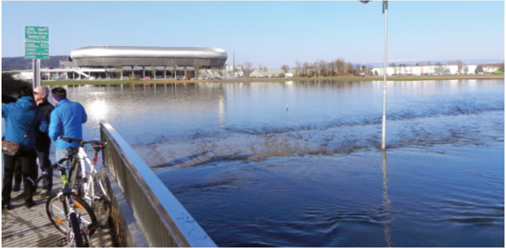
Abb. 7: Überschwemmungen sind im Untersuchungsgebiet eher selten und finden etwa alle 3 bis 5 Jahre vor allem in der Nähe der Glanfurt (Sattnitz) statt. Blick von der Brücke über die Glanfurt gegen das Wörthersee-Stadion. 25.2.2014. Foto: W. M. Franz
