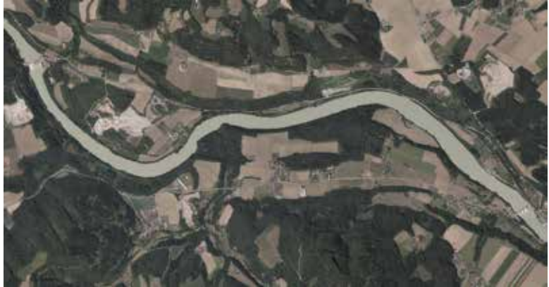
Abb. 14: Lage der Staustufe Lavamünd. Orthofoto: KAGIS
