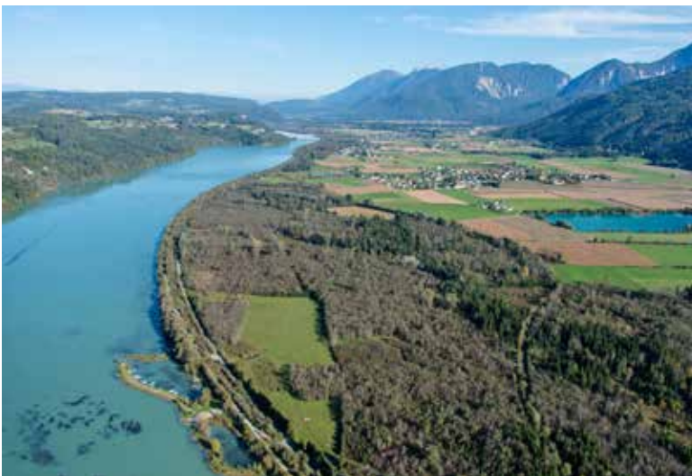
Abb. 27: Im Zuge der Errichtung des Kraftwerkes wurden große Auenwaldflächen vom Fluss getrennt. Foto: H. Pirker
