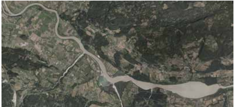
Abb. 9: Lage der Staustufe Feistritz. Orthofoto: KAGIS
