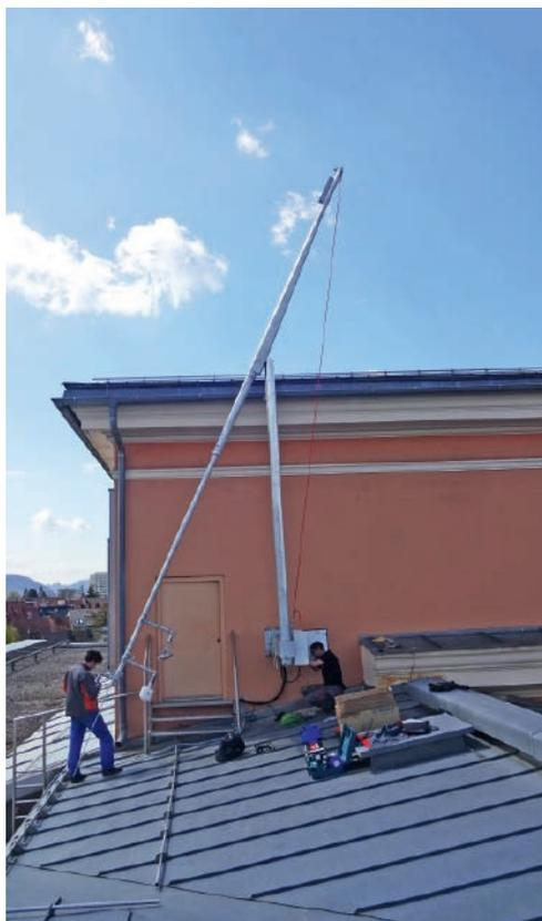
Abb. 9: Montage der Strahlungssensoren am (gekippten) Windmast der im April 2021 neu errichteten TAWES-Station Klagenfurt/HTL1-Lastenstraße.
