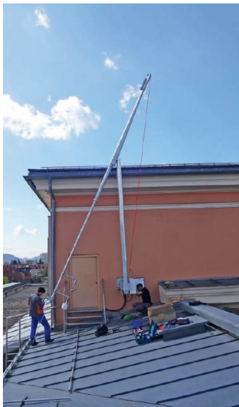
Abb. 9: Montage der Strahlungssensoren am (gekippten) Windmast der im April 2021 neu errichteten TAWES-Station Klagenfurt/HTL1-Lastenstraße. Foto: ZAMG
