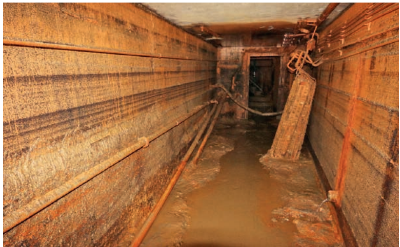
Abb. 5: Blick in das ausgepumpte Stollen- und Schachtsystem, Schacht unterhalb der Abfüllhalle Richtung Quelle I; 11. Juli 2020. Foto: M. Jungmeier
