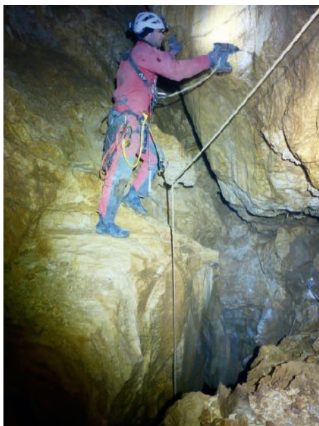
Abb. 17: Einbauarbeiten Schacht- verankerungen. Foto: M. Friedl.
