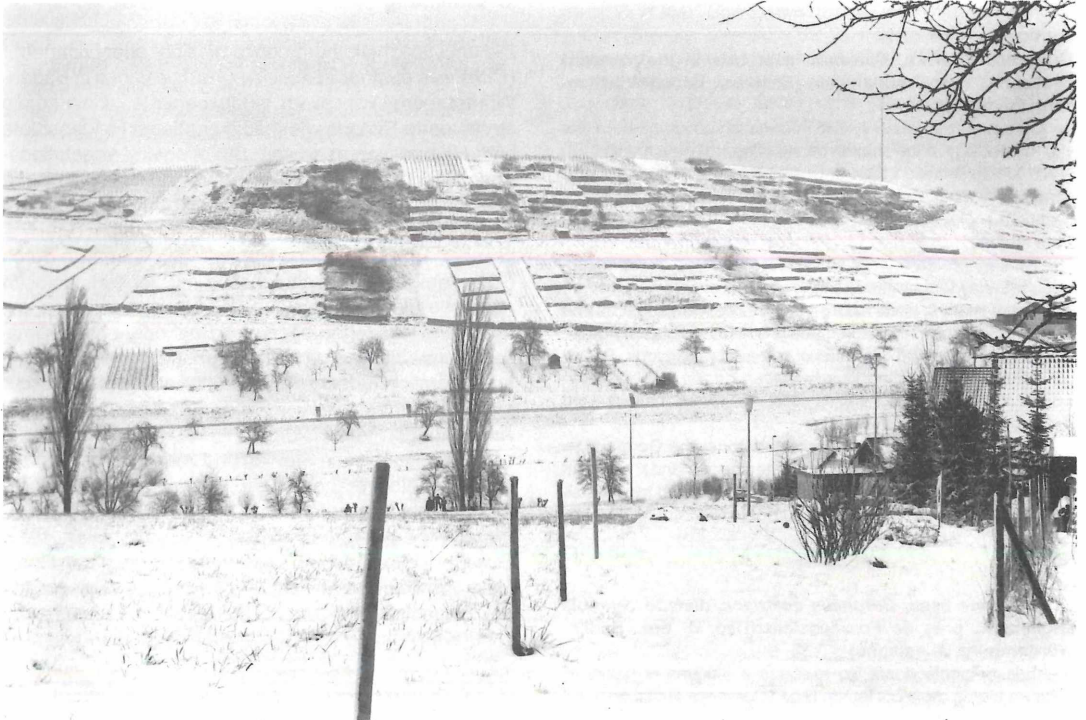
Abbildung 1. Gesamtansicht des Weinbergmauernkomplexes im Winter. Alle Fotos: P. ZIMMERMANN.
