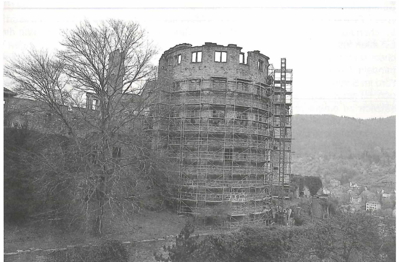
Abbildung 2. Bei den Sanierungsarbeiten am Apothekerturm wären ohne vorherige Untersuchungen zahlreiche Quartiere und Quartiermöglichkeiten für Fledermäuse verloren gegangen. – Foto: B. HEINZ
