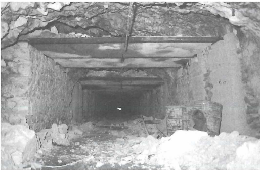
Abbildung 2. Oberer Hauptstollen (A), Innenansicht mit Ausbau. – Foto: Dr. C. KLIESCH.
