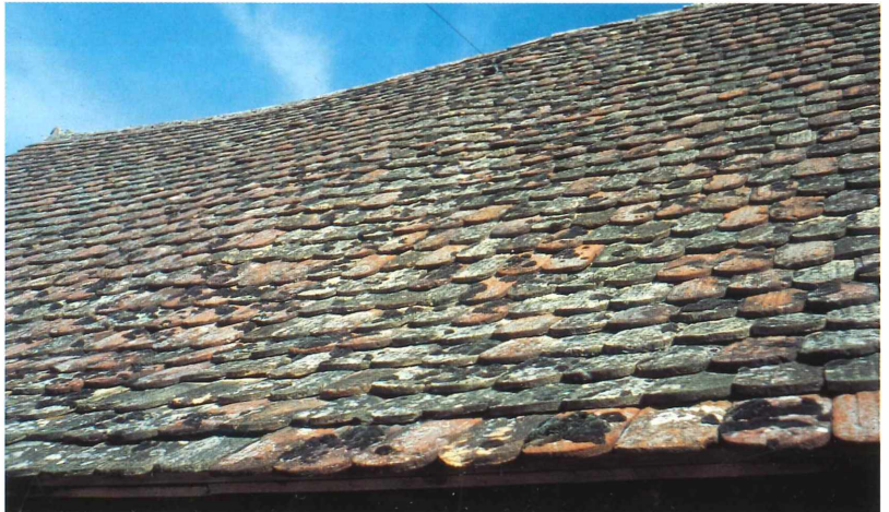
Tafel 2. c) Historisches Haus (1705) in Haltingen (Oberreinebene nördlich Weil a. Rhein) mit handgestrichenen Biberschwanz-Ziegeln (angeblich noch die Original-Ziegel). Auf der Südwest-exponierten Dachfläche siedelt Grimmia ovalis (schwarze Polster) im unteren Dachbereich und Grimmia laevigata (eher graue, flache Polster) über das ganze Dach verteilt. 12.07.97.
