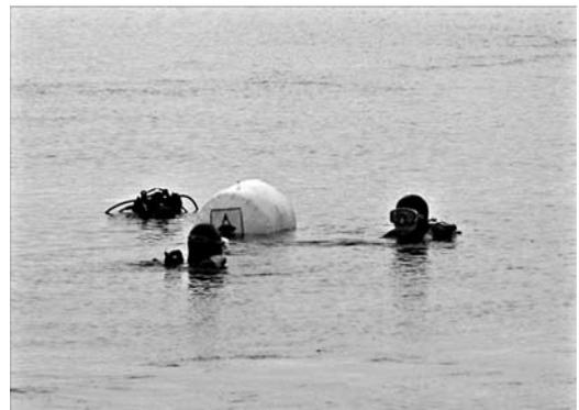
Abbildung 3. Taucher transportieren den Torfblock am Hebesack.
