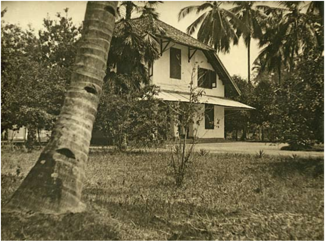
Abbildung. 2. Das Elternhaus „Mamadjang“ in Makassar auf Sulawesi (Indonesien) 1921/22. Der Name des Anwesens stammte angeblich von einem Geschäftsfreund des Vaters, der dort zuvor gewohnt hatte. Er dürfte auf das Viertel Mamajang in Makassar hindeuten, wo sich das Haus möglicherweise befand. – Foto: privat.
