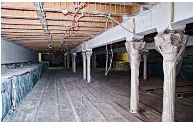
Abbildung 4. Über den abgehangenen Decken ist deutlich zu sehen, dass beim Wiederaufbau nach dem Zweiten Weltkrieg oft sehr pragmatisch vorgegangen werden musste. Die Schönheit des Berckmüllerbaues von 1865 bis 1872 hat durch Krieg und Mangel der Nachkriegszeit zweifellos gelitten.
