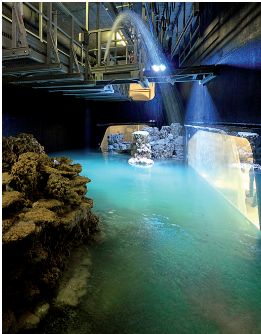
Abbildung 27. Anfang Juli stellt eine Probefüllung des großen Riffbeckens sicher, dass Scheiben und Gewölbe den Wassermassen standhalten.
