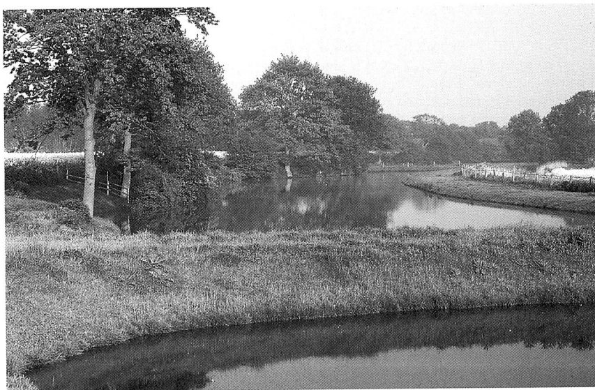
KT Altengörs (Nr. 32). Die Teicheinheiten (Typ: ub) sind durch Dämme getrennt und durch Siele verbunden. Fotos: THIES
