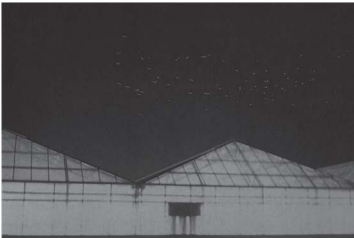
Die Gewächshausanlage in Albersdorf bei Nacht mit überfliegenden Zugvögeln Foto: G. Schultz
