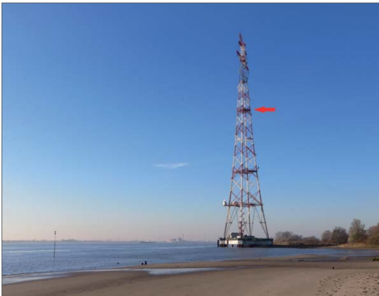
Abb. 1: Der 197 m hohe Freileitungsmast in Hetlingen, in dem die Wanderfalken gebrütet haben. Auf 117 m Höhe (roter Pfeil) befinden sich die Nisthilfen (17.11.2014, A. BRANDT).
