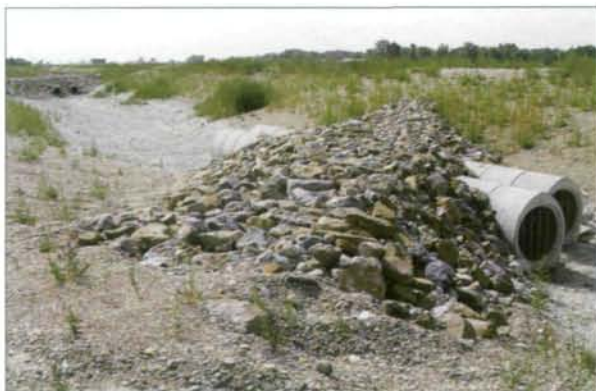
Abb. 3: Standort 3 – fertige Modellierung des Nebengerinnes vor dem Einstau. Einzelne Beckenabschnitte sind durch überschüttete Rohrdurchlässe miteinander verbunden. Foto: F. Michlmayr
