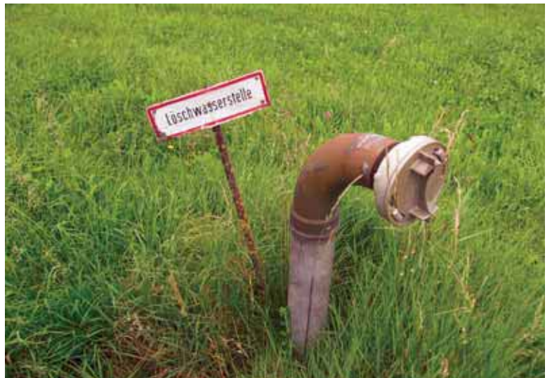
Abb. 2: Früher hatte jedes Bauernhaus eine Hauslacke, welche unterschiedliche Funktionen hatte (Löschwasser, Eisteich, Kühlteich, etc.). Heute sind sie weitgehend verschwunden, als Löschwasserbehälter fungiert ein unterirdischer Speicher. Geretsberg, Innviertel, 23.8.2007, Foto: W. Weißmair.
