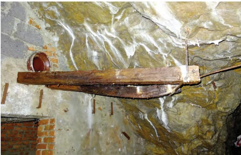
**Abb. 13:** Ein im Hauptgang gut sichtbarer – aber in Auflösung befindlicher – Holzbalken mit dem im Hintergrund liegenden Anschlussstück eines Keramikrohres zur Belüftung. (Foto: E. Fritsch).
