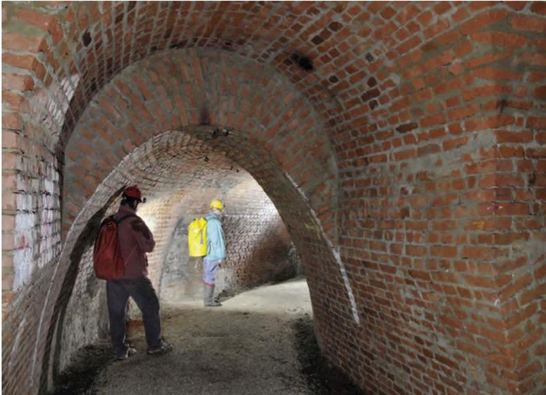
**Abb. 36:** Die auch ästhetisch anspruchsvolle Gewölbeausmauerung bei MP 3E zeugt von großer handwerklicher Kunst der Zwangsarbeiter. (Foto: H. Thaler).
