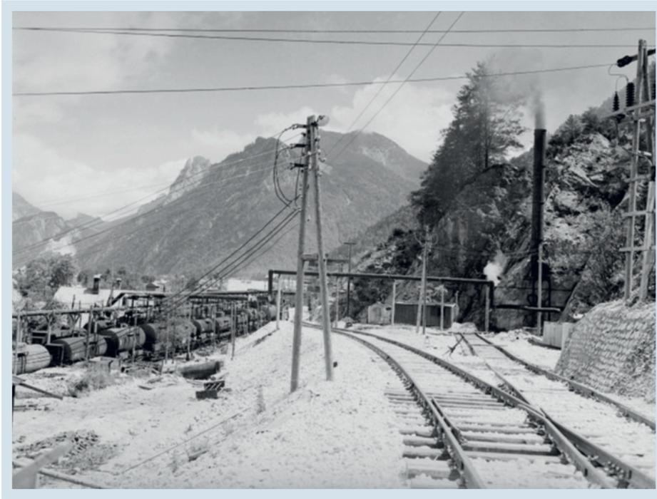
Abb. 7: Teil des Steinbruchgeländes mit der in die Stollenanlagen verlegten Erdölraffinerie, 1944. Links Kesselwaggons mit dem angelieferten Rohöl, rechts die Energiezentrale für die Anlage (ebenfalls in einem eigenen Stollen untergebracht).
