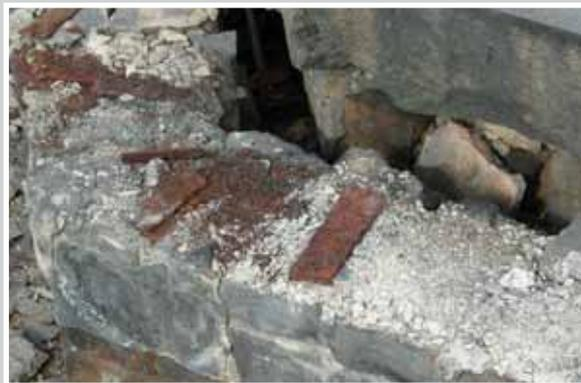
**6. OKTOBER 2008** Rostige Eisenkeile erweisen sich bei der Probeöffnung als eine der Ursachen für Verschiebungen der Granitplatten.
