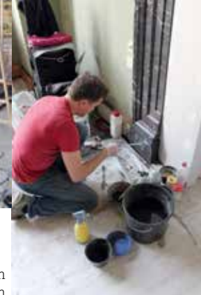
Stuckateur beim Ausbessern beschädigter Stellen
