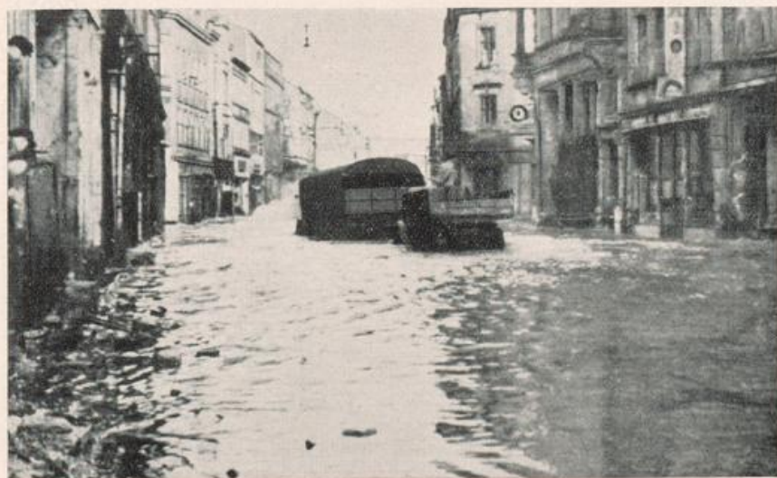
Abb. 13. Das Hochwasser an der Kreuzung Warndstraße - Eisenbahnstraße.
