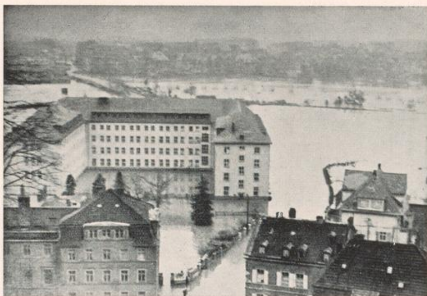
Abb. 14. Das Hochwasser an der Saargemünder Brücke.
