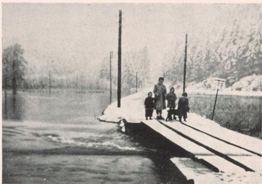
Abb. 6. Das Hochwässer der Roten Saar am 30. Dezember in Albrechtsweiler / Vogesen.
