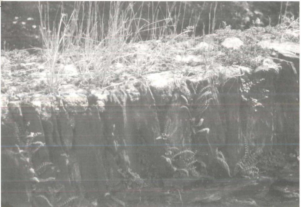
Abbildung 1. Mauer aus Quarzitschiefer. Mauerflanke mit NO-Exposition als Rollschicht, bewachsen mit *Asplenium trichomanes* (Brauner Streifenfarn) und *Asplenium ruta-muraria* (Mauerraute). Mauerkrone befestigt mit grobkörnigem Zementmörtel und besetzt von *Sedum album* (Weisse Fetthenne) und *Poa nemoralis* (Hain-Rispengras). Oberwesel, Juni 2000.
