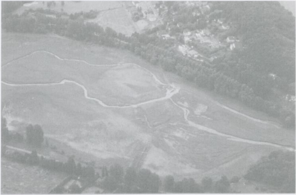
Abbildung 4. Der südliche Teil des trockengelegten Vorbeckens der Sorpetalsperre, Luftaufnahme von Südwesten (1996)
