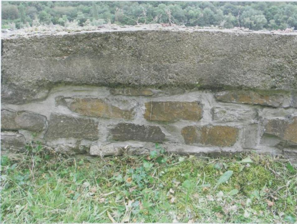
Abbildung 2. Mit Zementmörtel reparierte, vegetationsfreie Schiefermauer, Klotten/Mosel, (2.2.1) (Foto: 23.08.2008).
