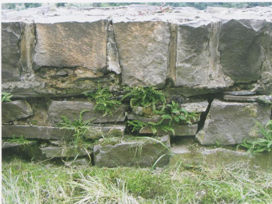
Abbildung 3. Unbearbeiteter Zustand der Schiefermauer mit Mauerfarnen, Klotten/Mosel (2.2.1) (Foto: 23.08.2008).
