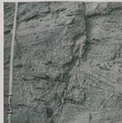
Abb. 5. Spießwinklig zur vorderen Wand streichende Verwerfung. Die Kluft ist von feinblättrigem Ton ausgefüllt.
