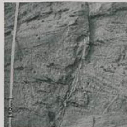
Abb. 5. Spießwinklig zur vorderen Wand streichende Verwerfung. Die Kluft ist von feinsblättrigem Ton ausgefüllt.
