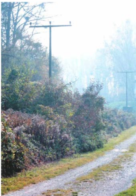
Abb. 3: Entlang von Wäldern geführte Stromleitungen können zur Waldrandgestaltung herangezogen werden und so einen wertvollen Beitrag zum Sicht-, Feind- und Witterungsschutz für Wildtiere bieten ...
