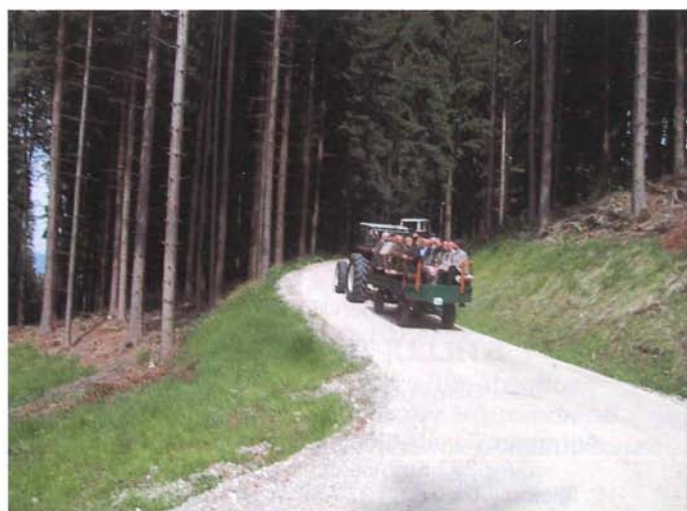
Elegante Linie im Gelände – fertig begrünzte Böschungen.
