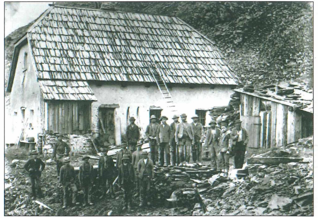
Abb. 8: Schutzhaus "Neubau" nahe Augustinstollen.
