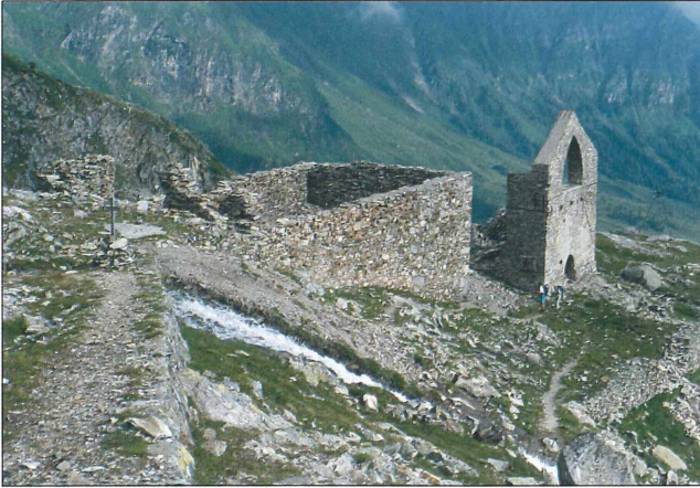
Abb. 9: Radhaus (Aufzughaus) des Rauriser Goldbergbaues.
