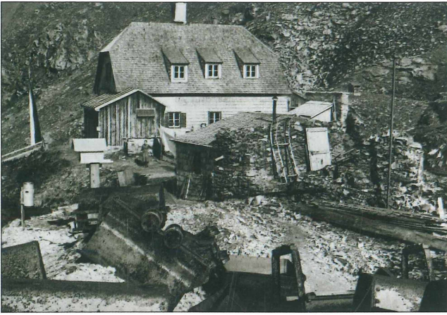
Abb. 7: Schutzhaus "Neubau" nahe Augustinstollen.
