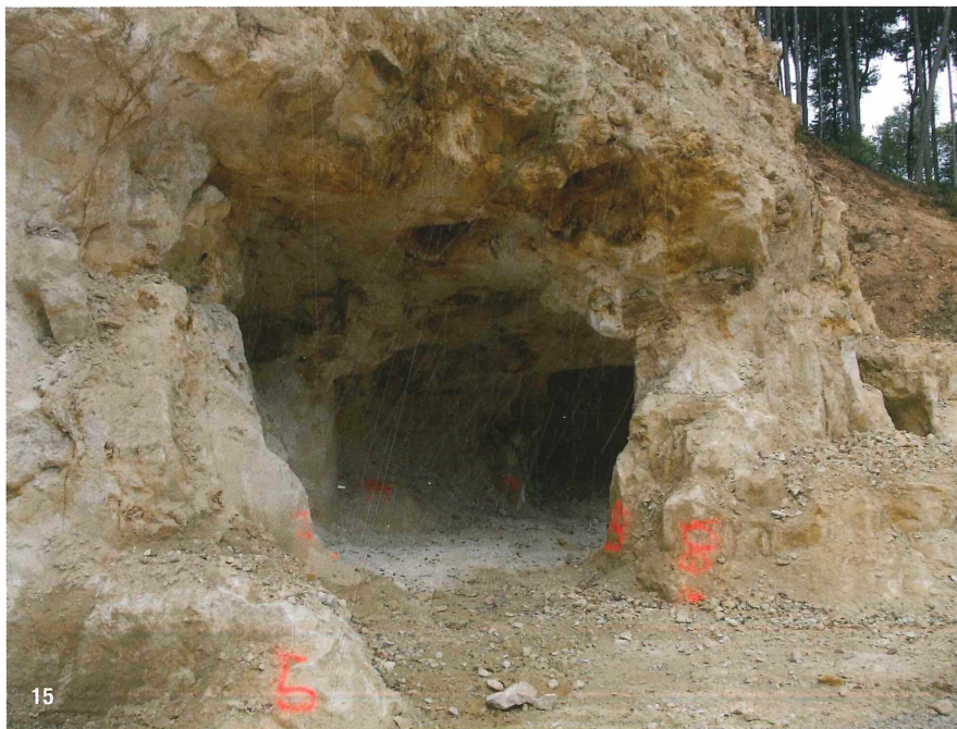
Abb. 15: Die unterirdisch angelegten Abbaukavernen einer früheren Abbauperiode wurden im Zuge von Steingewinnungsarbeiten für den aktuellen Forststraßenbau freigelegt, Situation Anfang September 2013.
