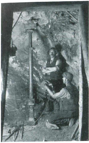
Abb. 4: Kurbelstoßbohrmaschine mit aufgesetztem E-Motor an einer Spannsäule geführt (FEUCHTER 82/1934, S. 178, siehe auch Anm. 5).
