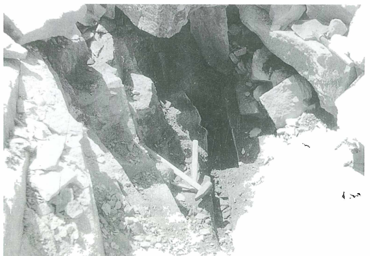
Abb. 3: Die Pfahl-parallel verlaufende Mineralklufft am Teufelstisch (Foto: Pfaffl)
