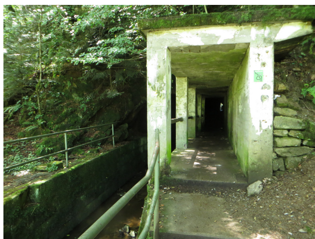
Abb. 4: Baudenkmal Trift-Tunnel (Foto: A. Zechmann)
