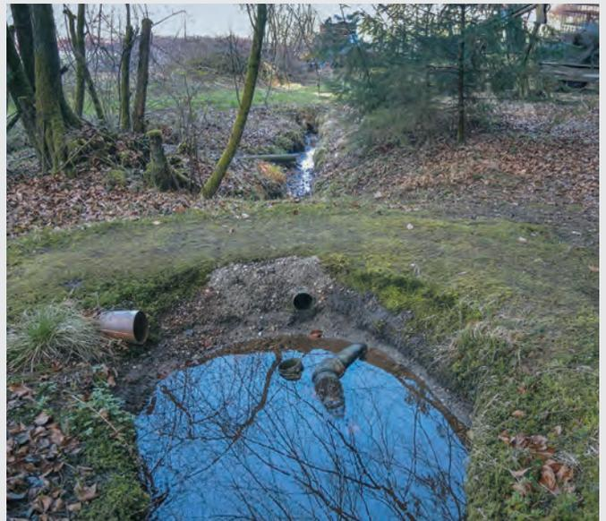
Abb. 26: Komplett-Ableitung des Lindelbauern-Bachls am Waldeck bei Punkt N 48.57485° E 013.35215°. Im Hintergrund der Graben, der die Verbindung zum Gründoblbach herstellen sollte, doch die beiden dafür gedachten Ausleitungsrohre liegen dafür viel zu hoch.
