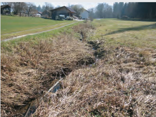
Abb. 21: Südteil von Abschnitt 2b in Richtung landwirtschaftliches Anwesen mit Rohrteilen auf der Sohle.
